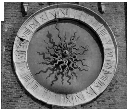
Fig. 1 - Il quadrante della Torre di Sant'Andrea.
